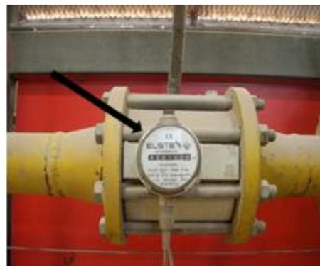
**Figura 4.** Medidor de gas utilizado para toma de datos
