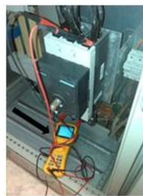
**Figura 5.** Pinza amperimétrica utilizada
