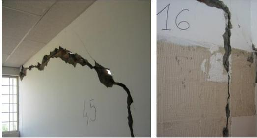
Figura 1. Daños producidos por expansión del suelo
