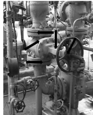
Figura 8. Punto de posicionamiento para una válvula tipo Globo con accionamiento manual Fuente: Elaboración propia
