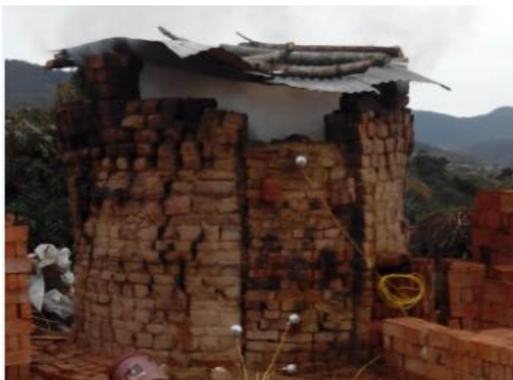
Figura 1. Horno ladrillera el recreo 2 Fuente: Elaboración propia
