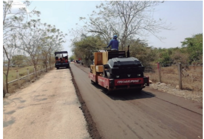
Figura 7. Compactación con compactador doble rodillo.
