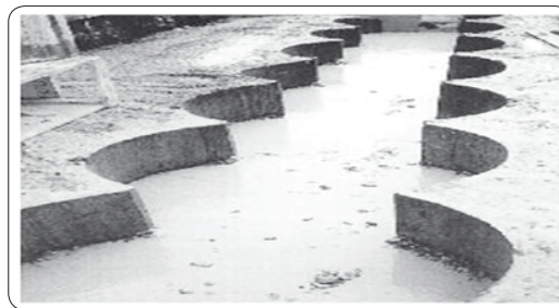
Figura 9. Sistema de contención en pilotes secantes (Rosas, 2011)
