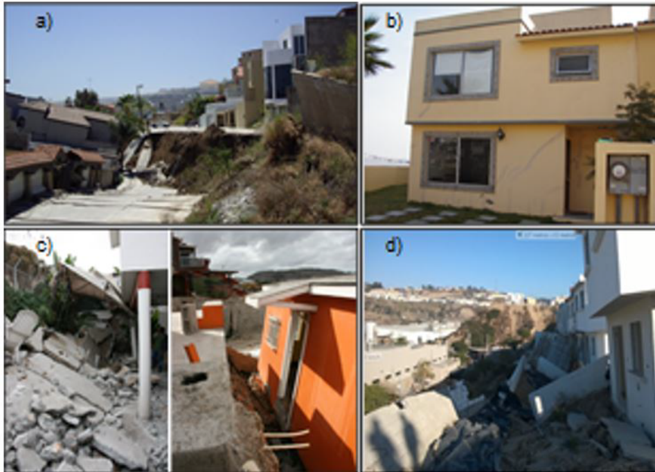
Figure 2. Damage caused by ground instability phenomena. a) Fraccionamiento Laderas de Monterrey (2010), b) Fraccionamiento El Palmar (2011), c) Fraccionamiento Terrazas de la Presa (2013), d) Fraccionamiento Valle Sur (2017). Source: Municipal Directorate of Civil Protection, Tijuana
